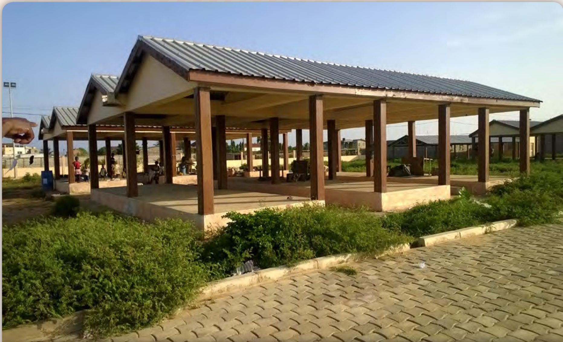
Marché au Togo construit avec le soutien de la BAD.
